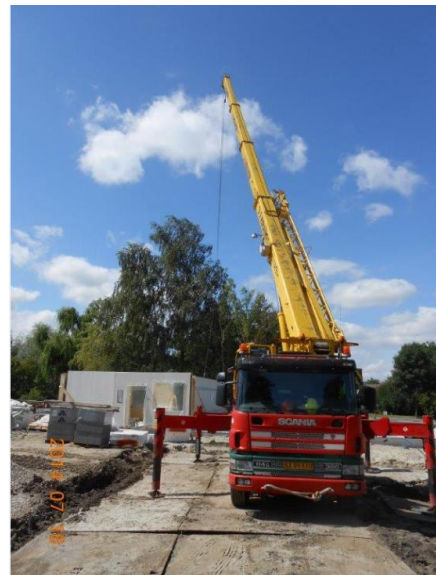
foto fra vægmontagen på blok 3.
